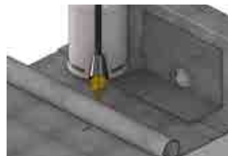
9. Prilydykite antrą hidroizoliacijos sluoksnį
