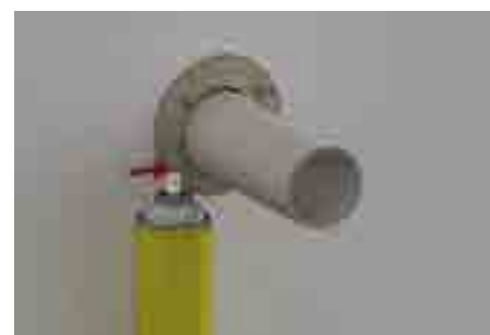
12. Ertmė tarp vamzdžio ir fasado užpurškiama putomis
