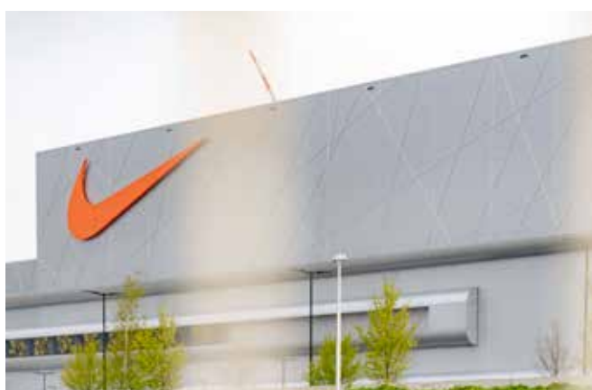
Nike Distributiecentrum - Belgium - AVS Unit heater
