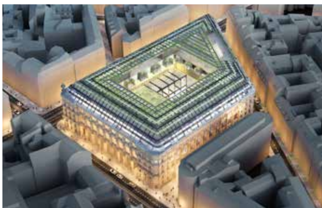
Poste du Louvre - France - Clima Canal
